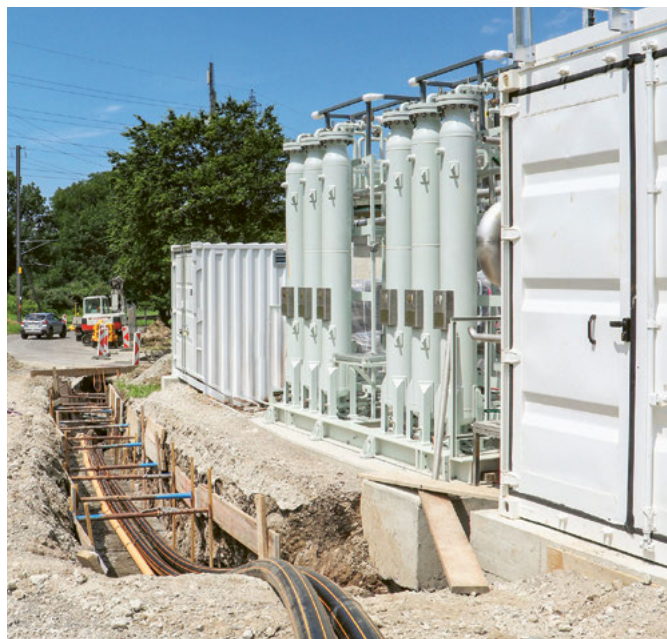
Une nouvelle installation de traitement du biogaz a été livrée sur le site du SIGE à Roche, nécessitant la pose de nouvelles conduites. La mise en service est prévue en septembre 2024.
