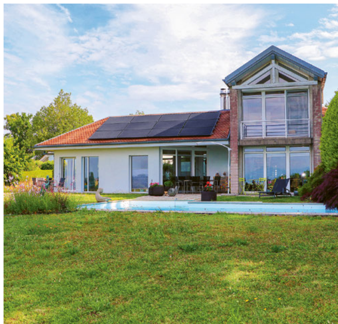
Taxa SA a effectué l'assainissement énergétique d'une villa à Vaux-sur-Morges, comprenant l'installation d'une chaudière à bois ainsi que la pose de panneaux solaires photovoltaïques.
