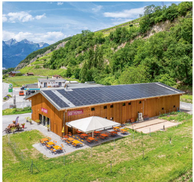
Près de 600 m 2 de modules photovoltaïques ont été posés par Agena SA sur le toit de Badan Vins, à Ollon, dans le cadre d'un contracting solaire d'Energiapro SA. La production d'électricité renouvelable estimée est équivalente à une consommation moyenne annuelle de près de 35 ménages.
